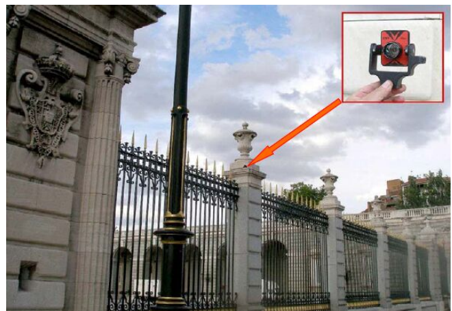
Fig. 17 Miniprismas en edificios adyacentes
