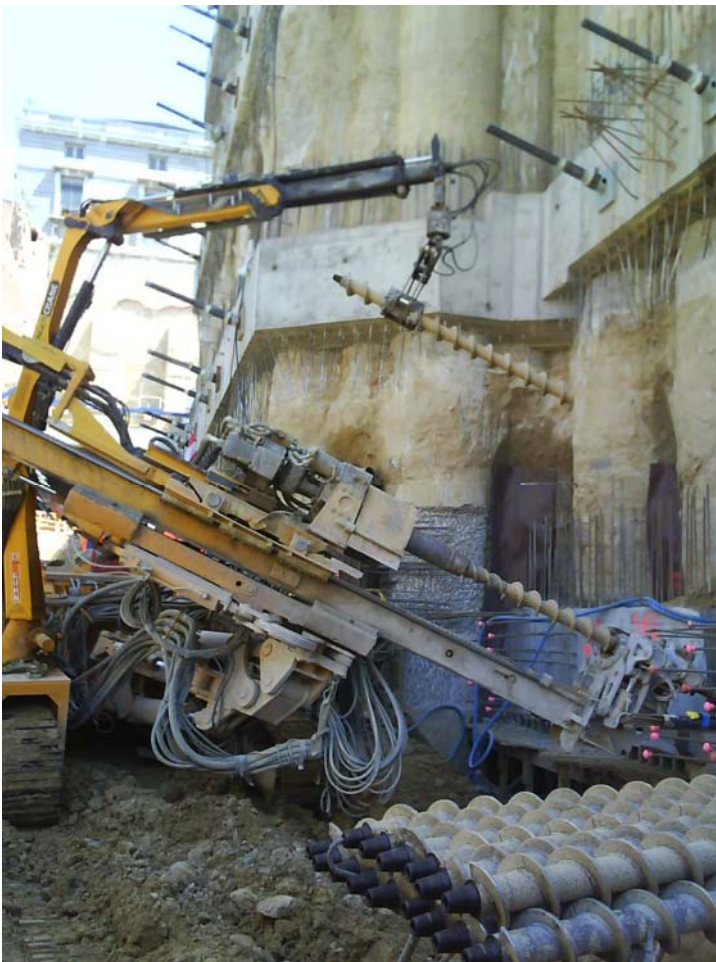
Fig. 6 Ejecución de anclajes al terreno
