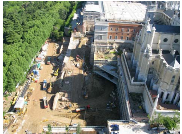
Fig. 4 Estado de las obras en mayo de 2008
