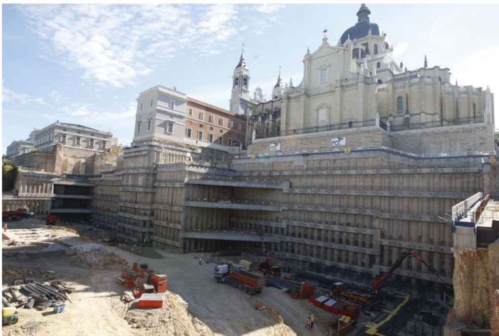
Fig. 5 Estado de las obras en agosto de 2008
