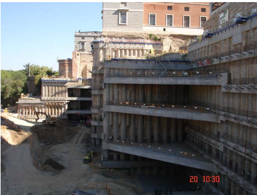
Fig. 9 Losas de acodamiento
