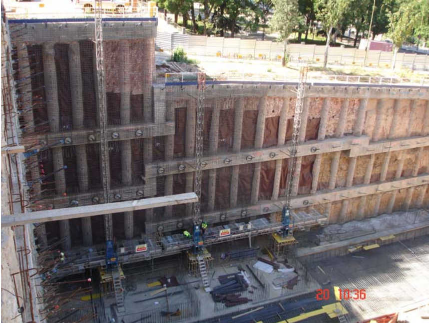
Fig. 10 Ferrallado de muro forro y contrafuertes
