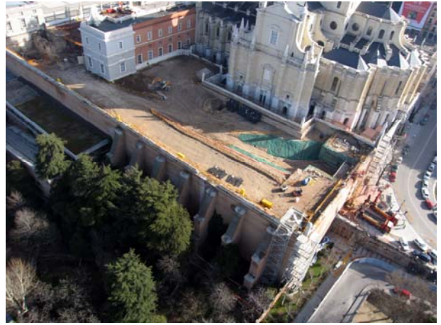
Fig.2 Estado de las obras en febrero de 2007
