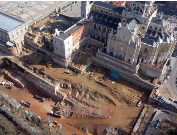
Fig. 3 Estado de las obras en febrero de 2008
